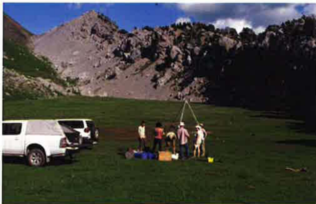
Figura 8. Perforación de sondeo mecánico de 22m de profundidad con testigo continuo en el punto bajo del "polje" de La Estiva (Drilling a well to 22m deep in La Estiva "polje" lowest point)
